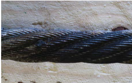
Lämpövauriot Lankojen värimuutokset, voitelun häviäminen, lankojen arpeutuminen
